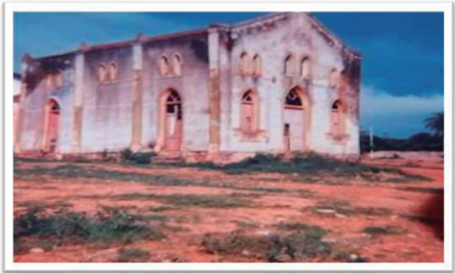
Imagem 2: Capela com sinais de abandono
